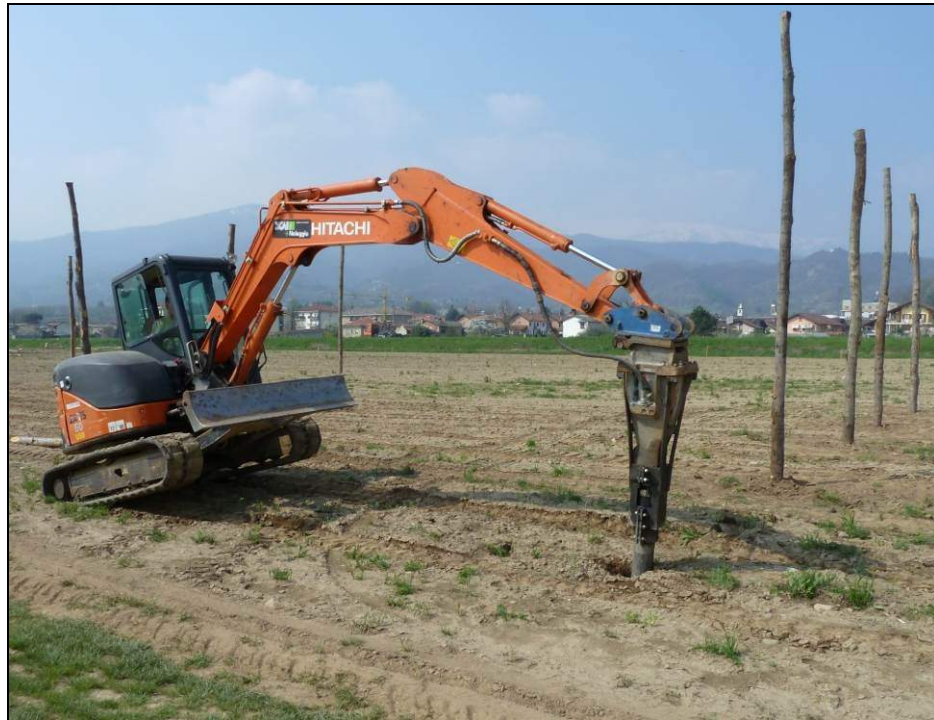
Fig. 13- Predisposizione della buca per la collocazione del palo mediante martello pneumatico applicato all'escavatore
