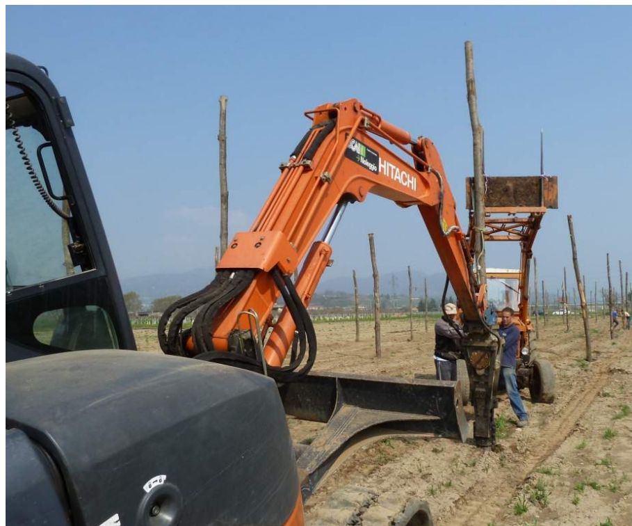
Fig. 14- Infissione del palo a pressione con escavatore
